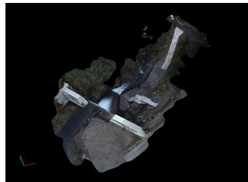
3D データ(着工後)
