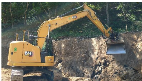
ICT 建機による施工の様子
